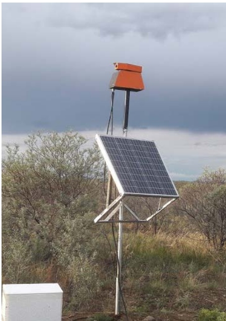
10-р зураг. Хархорины чацарганы талбайд байрлуулсан анхны төхөөрөмж
