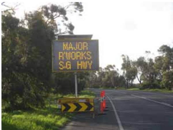
100 км/цагийн хурдны хязгаартай (зүүн гарын дүрэмтэй) хөвөөний гадна байршуулсан чиргүүл дээр суурилуулсан солигддог мэдээллийн тэмдэгийн жишээ.
