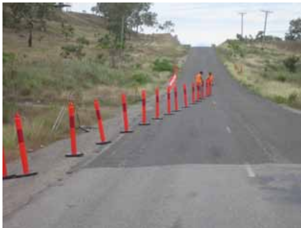
Конус болон зөөврийн шонг замын голдрил өөрчлөлтийг тэмдэглэхэд 5 м алхамтай байрлуулах нь зохистой.
