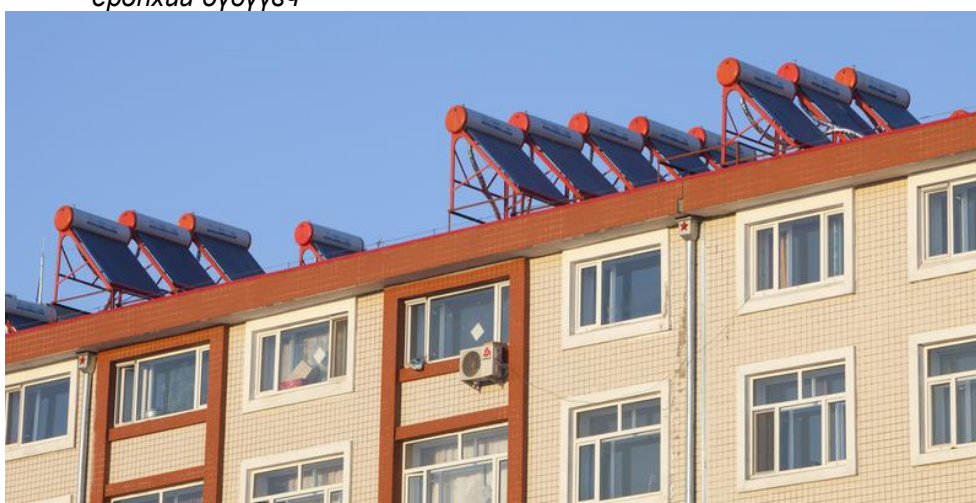
Зураг 4.5. Орон сууцны дээвэр дээр ХХУ-ны нарны халаагуур суурилуулсан байдал /БНХАУ, Хөх хот/
