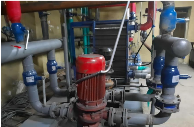
Зур.2.20. УДДТ-1. /15, 16, 17, 18, 19, 20-р 6 орон сууц/ халаалтын буцах шугамд эргэлтийн насостой.
