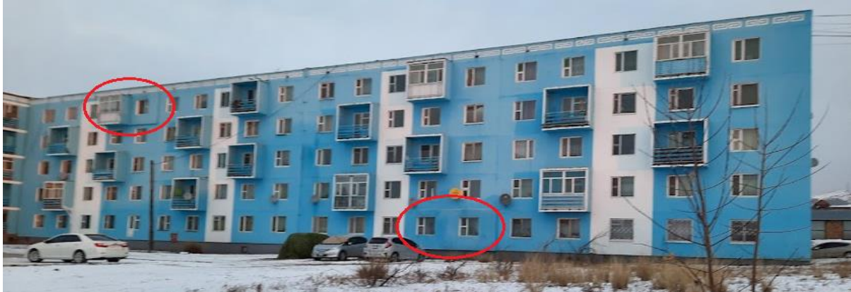
Зур.2.30. 19-р байрны суугчид өөрсдөө гадна ханаа дулаалсан байдлыг улаанаар дугуй тэмдэглэв.
