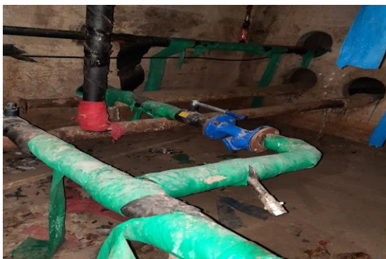
Зур.2.22. 19-р байрны техникийн давхар дах халаалтын оролтын зангилаа. Хаалт, юүлэгчтэй.
