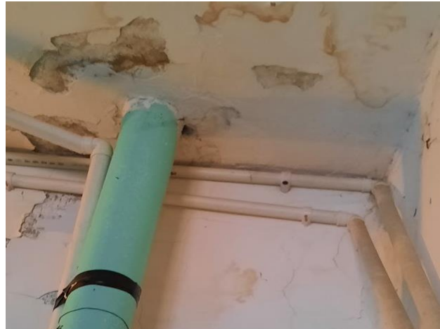
Зур. 2.7. Дээрийн борооны усны хоолойн орцонд байрласан. Хоолойг дагаж ус нэвчдээ.
