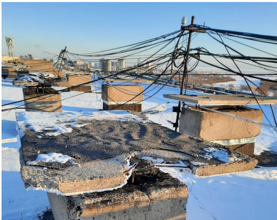
Зур.2.26. Дээвэр дээрх агаар зайлуулах шахтын байдал.
