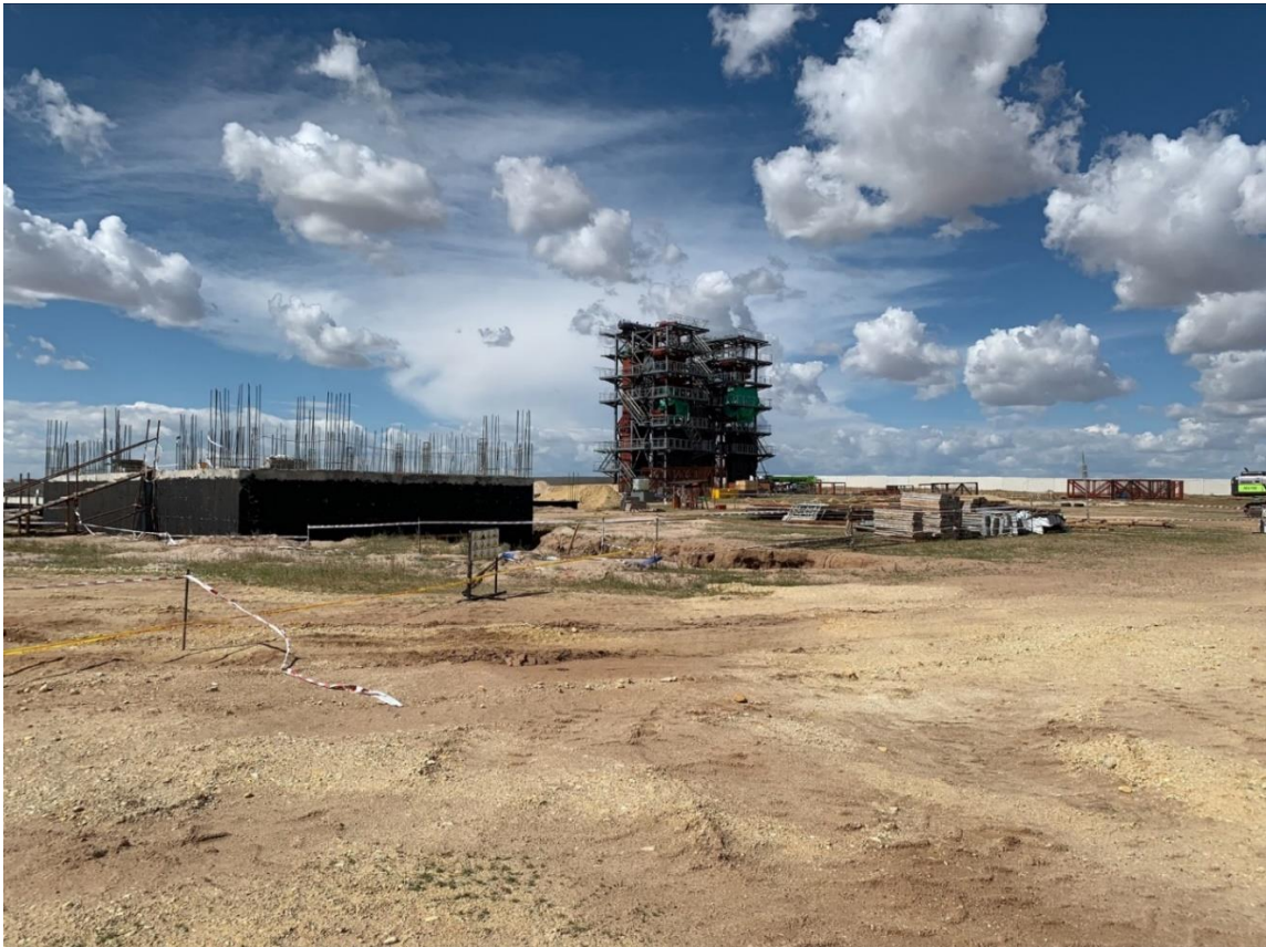
Зураг 5-3 Чойр 20 Гкал/ц хүчин чадалтай Дулааны станц баригдаж буй байдал
