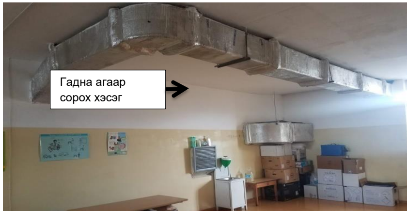
Зураг.1 ХӨСҮТ-ийн Сүрьеэгийн тасгийн 5 давхрын гадна агаар сорох хэсэг ердийн тасалгаанд байрлаж байгааг харуулсан зураг
