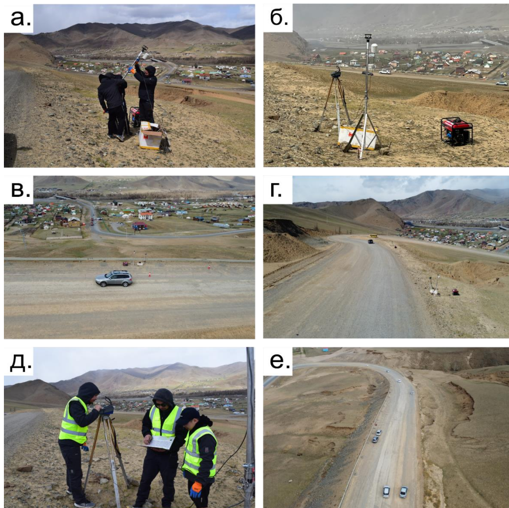
Зураг 2.9. Тоосжилтын хэмжилтийн үйл явц: а) DustTrak, цаг уурын станц угсарч суурилуулж буй байдал; б) Хэмжилт хийж буй байдал; в) ПК0+360 дээр байршуулсан хэмжилтийн багажууд; г) ПК0+140 болон ПК0+060 дээр байршуулсан хэмжилтийн багажууд; д) багажийн хэвийн ажиллаж буйг шалгаж буй үзлэг; е) Тоосжилт хэмжилтийн үеийн нөхцөл байдал;
