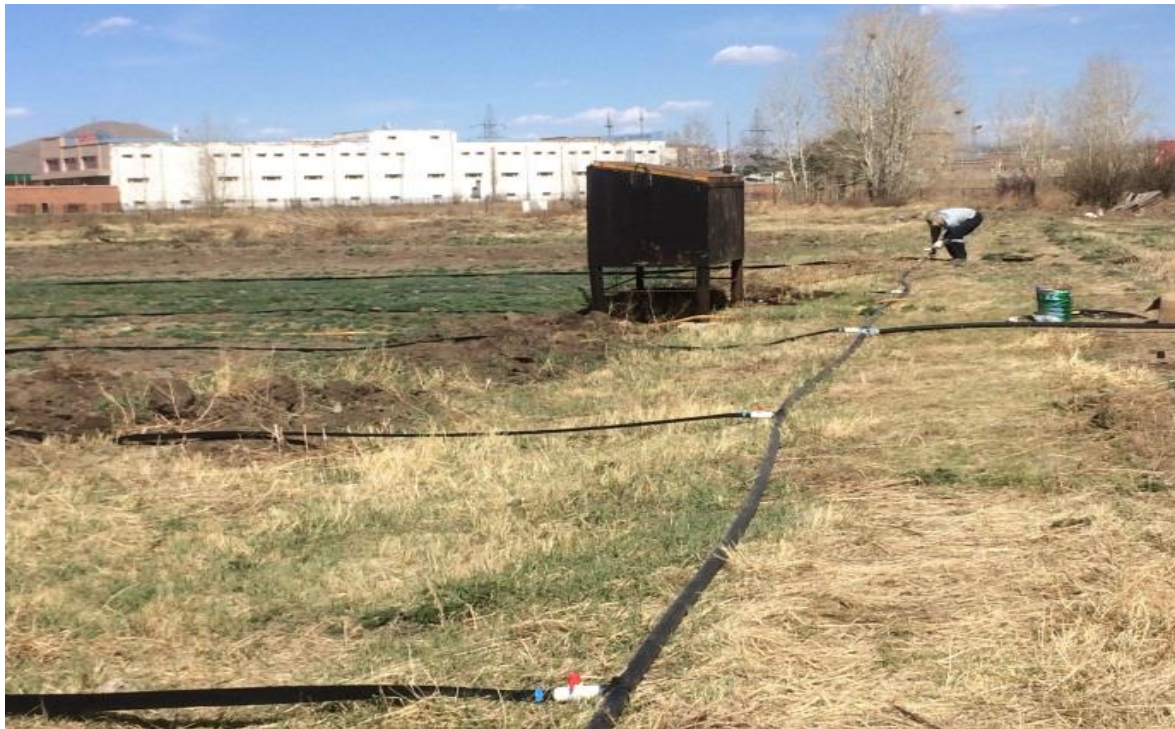
Зураг 42. Усалгааны системг угсарч буй ерөнхий байдал
