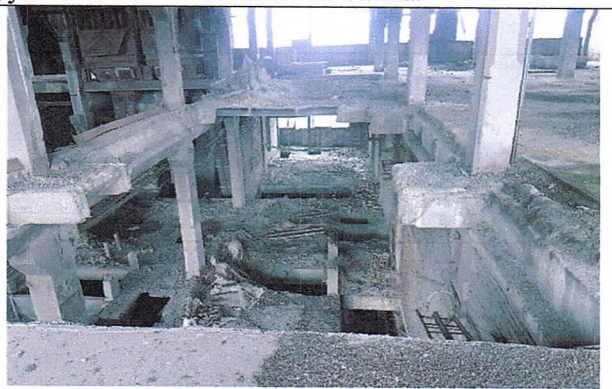
14-р зураг. 2-р давхарын хучилтын хэсэг. Метал дамнурууг буулгаж авсан байна.
