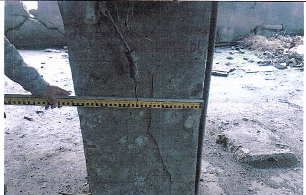
9,10-р зураг. Баганын хөндлөн огтлолыг шалгаж байна. 1,2-р давхар 400x600мм
