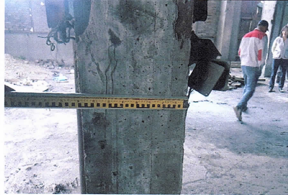
9,10-р зураг. Баганын хөндлөн огтлолыг шалгаж байна. 1,2-р давхар 400x600мм
