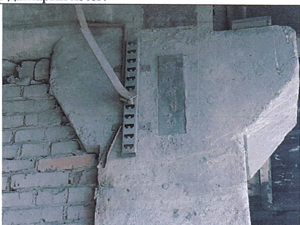
45,46-р зураг. 2-р давхарын багана хоорондын холбоосыг бэхлэх деталь
