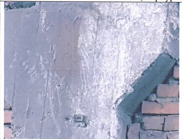
45,46-р зураг. 2-р давхарын багана хоорондын холбоосыг бэхлэх деталь
