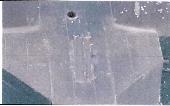
23,24-р зураг. Багана хоорондын холбоос бэхлэх деталь, метал холбоосыг тайрч төмрийн хогонд тушаасан даа.
