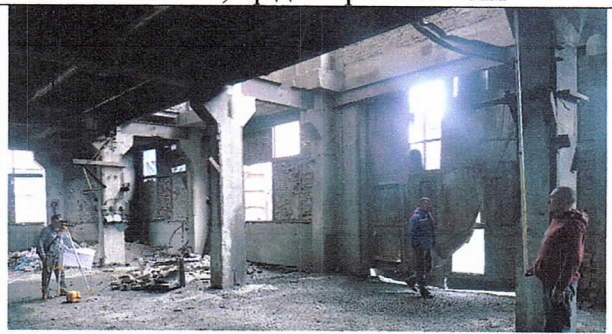
11,12-р зураг. Хучилтын дамнурууны хэв гажилтыг шалгаж байна.
