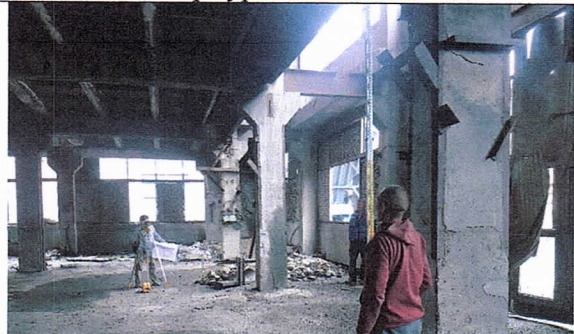
11,12-р зураг. Хучилтын дамнурууны хэв гажилтыг шалгаж байна.
