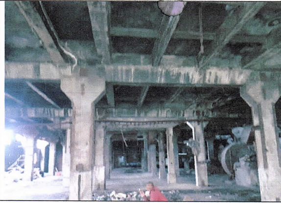
8-р зураг. Багана хоорондын металл холбоосыг буулгасан суурь нь үлдсэн байна.
