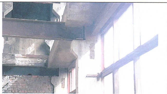
51-р зураг. А-Б тэнхлэгийн хоорондох хэсэг. Метал дамнуруу, хоосон хөндийн зай.
