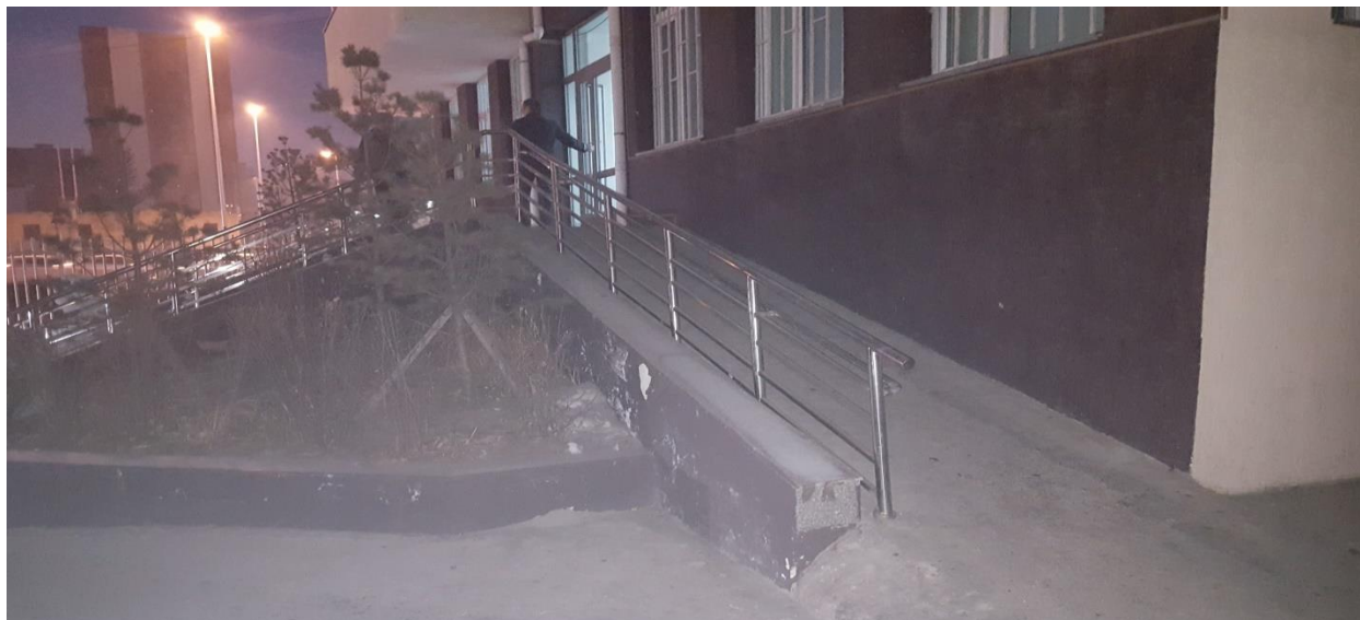
Зураг.НШШГ-ын байранд налуу шат хийгдсэн байдал
