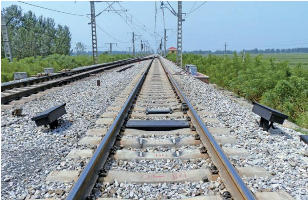
Зураг В.28. Ачааны хөдлөх бүрэлдэхүүний тээврийн гэмтлийн хөдөлгөөнтэй зургийг хянах систем
