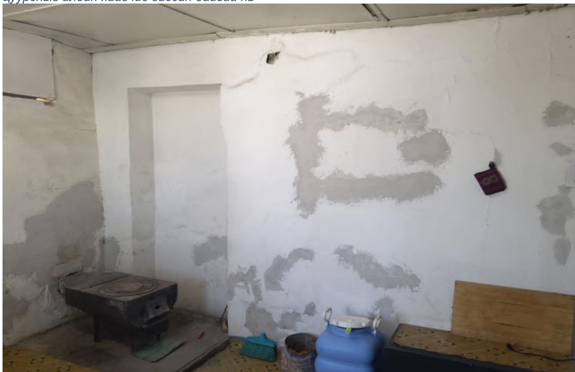
Зураг 2. Цагааннуурын боомт дээрх албан хаагчдын амьдрах байрны дотор хана цуурсныг албан хаагчид зассан байгаа нь
