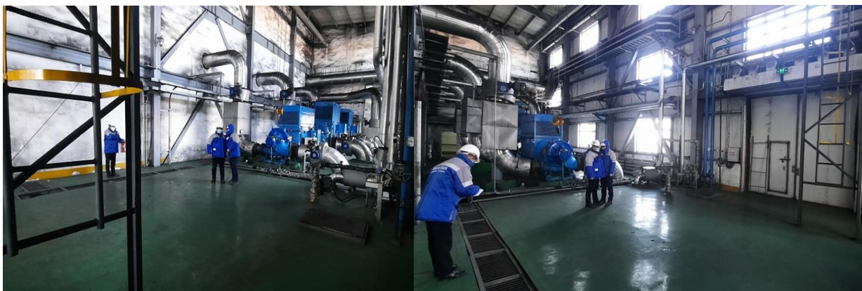
Зураг 4.8. Сүлжээний усны насосны байршил, зай талбай
