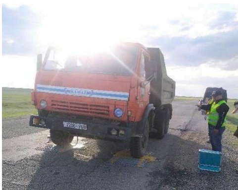
УБ-Чойр чиглэлийн авто замд хэмжилтийн автомашины ачааллыг хэмжиж байгаа нь
