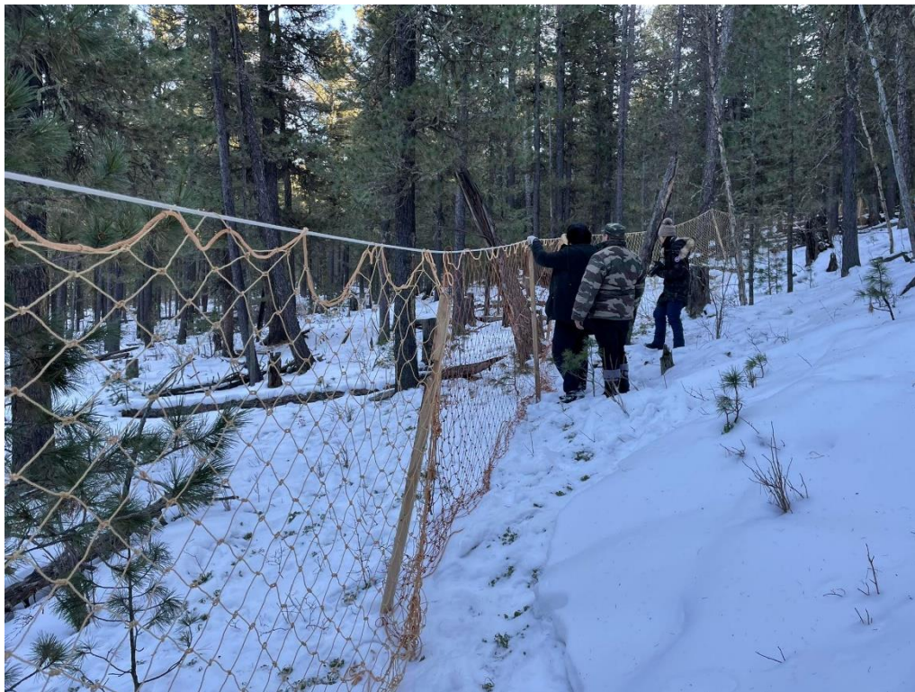
Зураг 8. Хүдэр барих тороо суурилуулж буй байдал.
