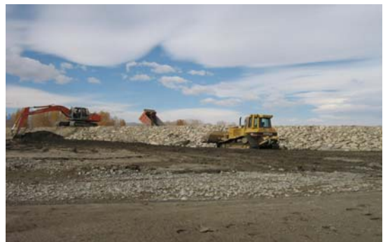
Шороон боомт дундаа шавар зүрхэвчтэй, дээд суурийн налууд чулуун өнгөлгөөтэй
