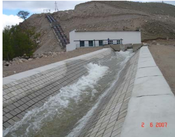
Түрэлтийн хоолой, станцын байшин, хаях суваг
