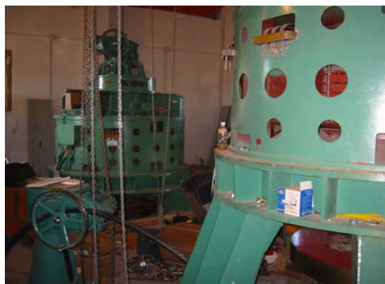
УЦС-ын босоо тэнхлэгт 250 кВт, 125 кВт-ын турбин
