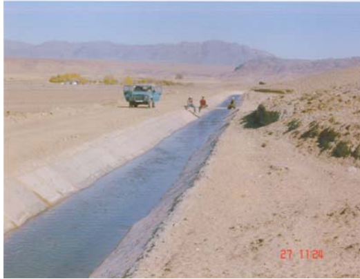
Төмөр бетон хавтан доторлогоотой деривацийн суваг
