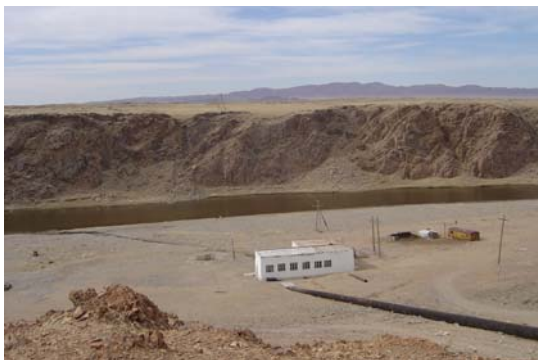
УЦС-ын байшин, түрэлтэт шугам, ус хаях суваг
