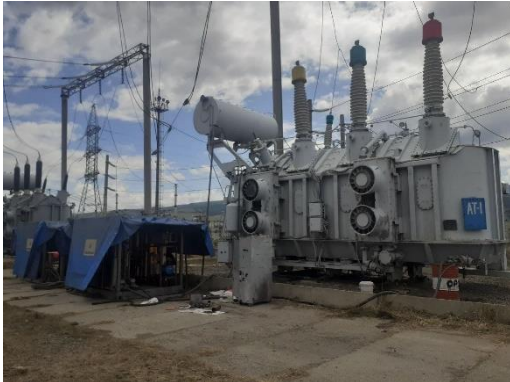
Зураг 1. Цэвэрлэх төхөөрөмжийн трансформаторт холбосон байдал
