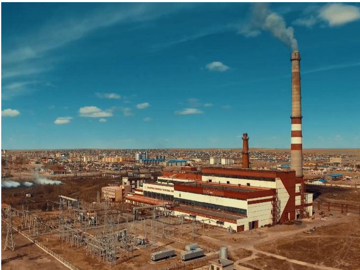
Зураг-2.8. Чойбалсангийн ДЦС-ын гаднах байдал
