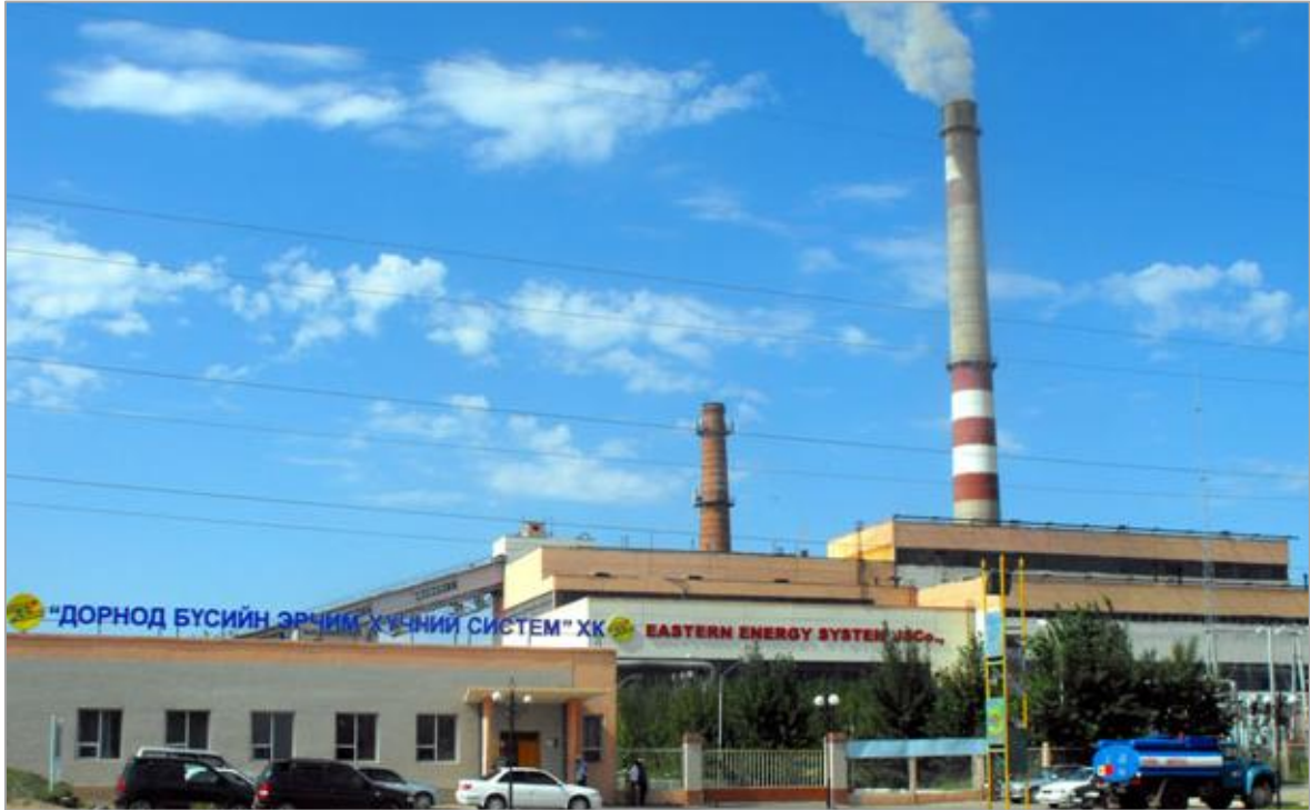
Фото 1.1. Дулааны цахилгаан станцын ерөнхий байдал
