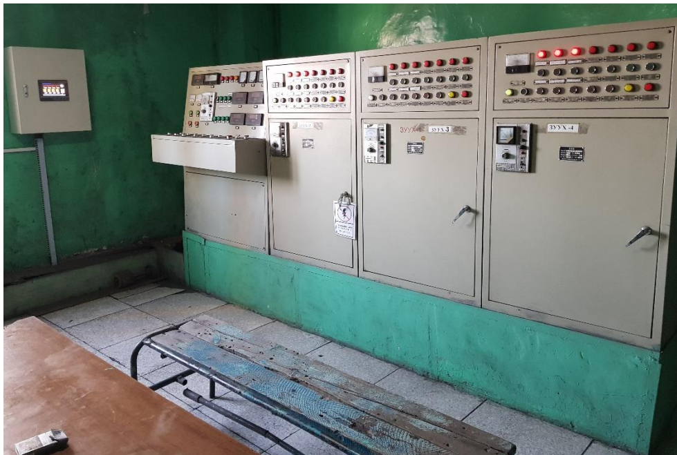
Зураг III.10. Дулааны станцын 4 ус халаах зуухны удирдлагын самбар
