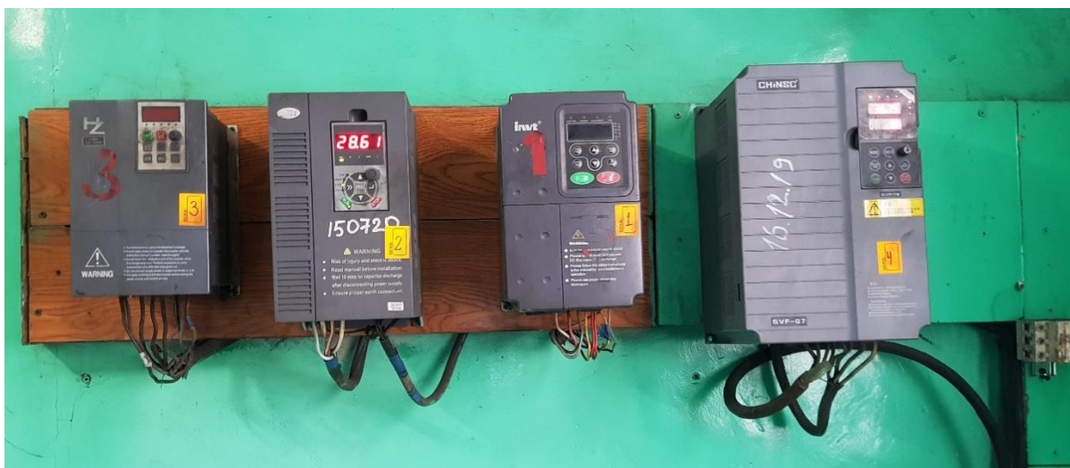
Зураг III.11. Зуухнуудын ул ширэмний давтамж хувиргуурууд
