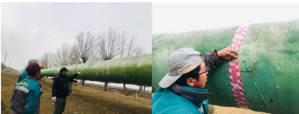
Зураг 3.4. Температурын мэдрүүрийг зөв байрлуулах зааварчилгааг хэмжилтийн бодит цэгт өгч байна
