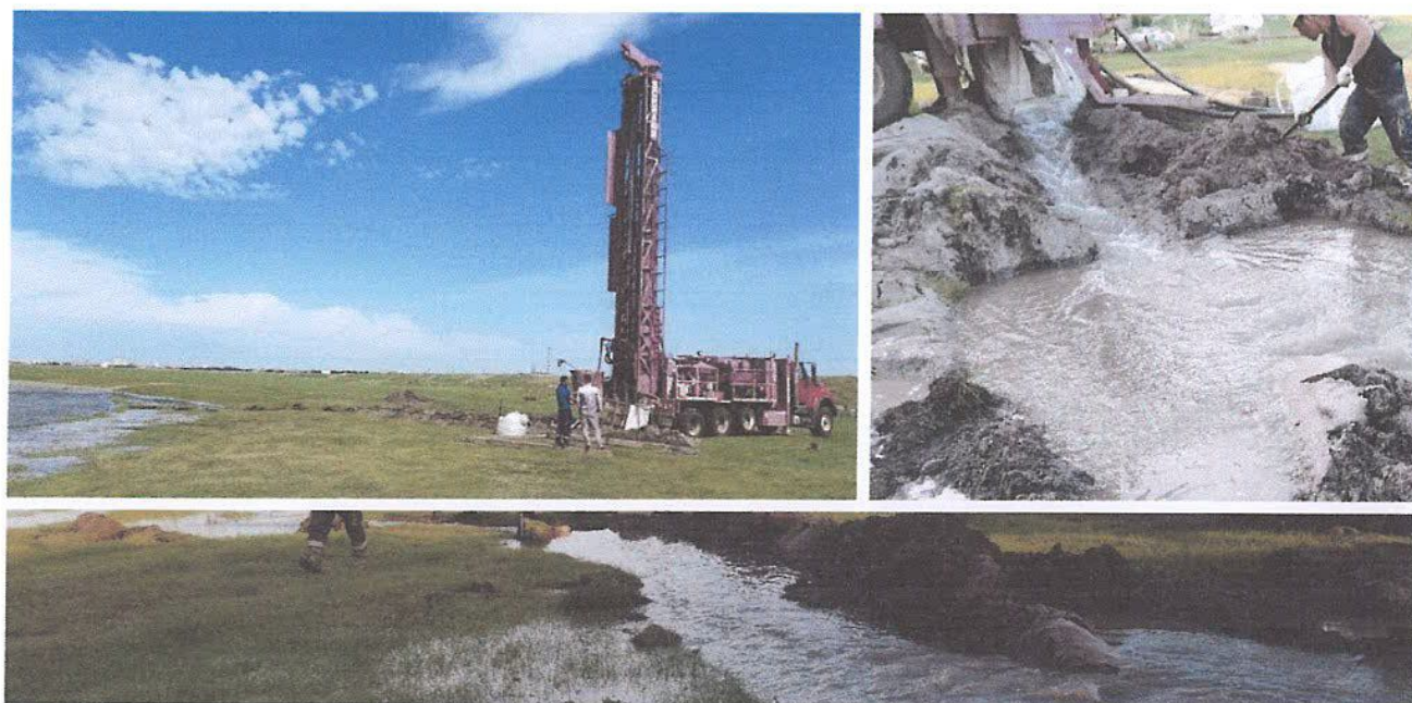
6-р зураг. Цооногийн цэвэрлэгээний ажил хийгдэж буй байдал
