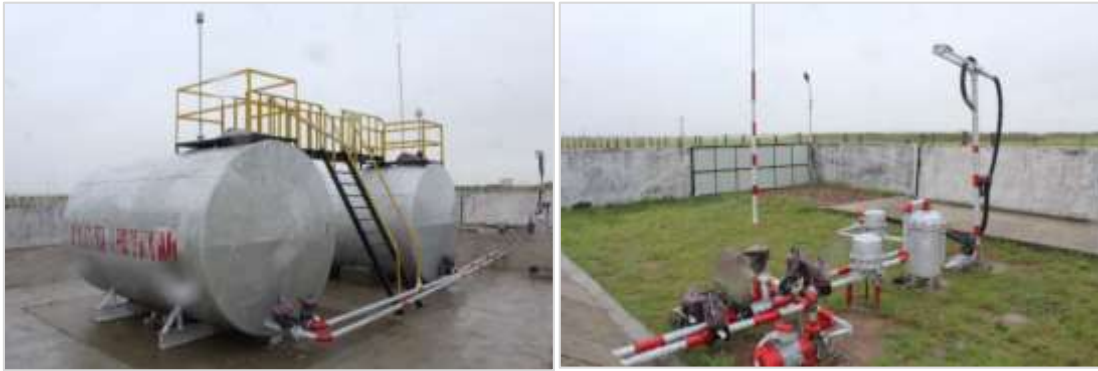
Зураг 2.9. Нисэх буудлын шатахуун нөөцлөх сав, дагалт тоноглолууд, 2019-VIII
