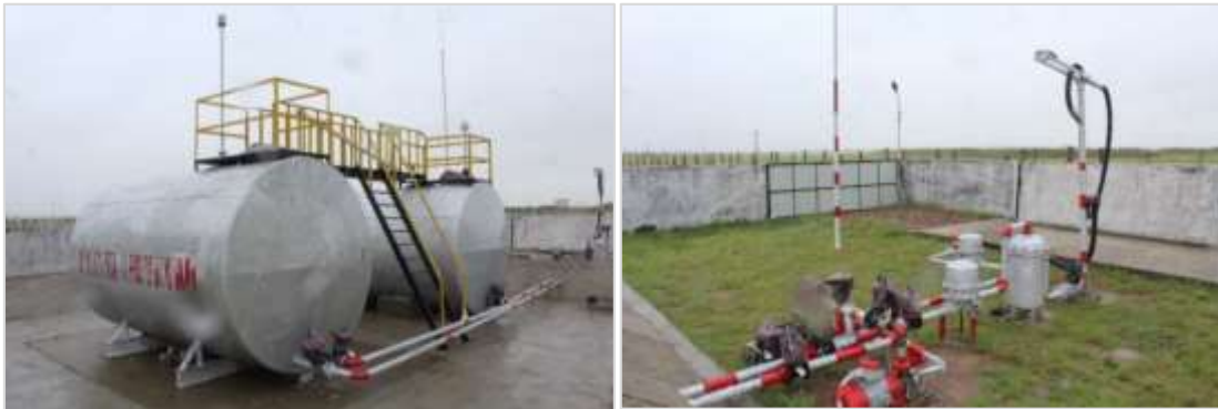
Зураг 6.1. "Нисэх буудлын шатахуун нөөцлөх сав, дагалт тоноглолууд
