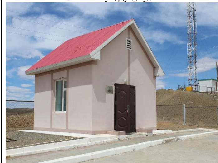
8.Өлзийт сум, Цэвэршүүлэх станц
