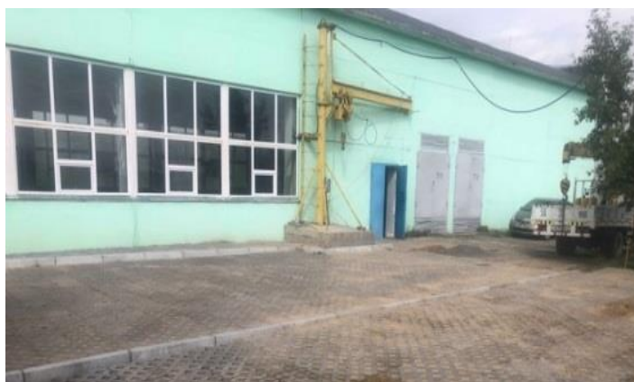
Зураг 18. Насос станц, ус хуримтлуулах бак
