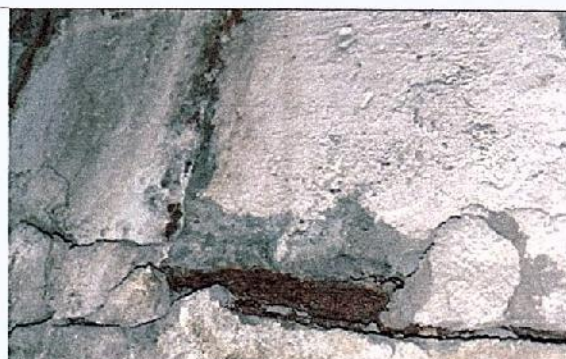
4,5-р зураг. Зоорийн давхар, 1-2-А тэнхлэгийн дамнуруун арматур коррозод орсон байна.
