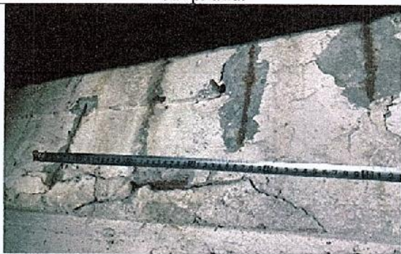
4,5-р зураг. Зоорийн давхар, 1-2-А тэнхлэгийн дамнуруун арматур коррозод орсон байна.
