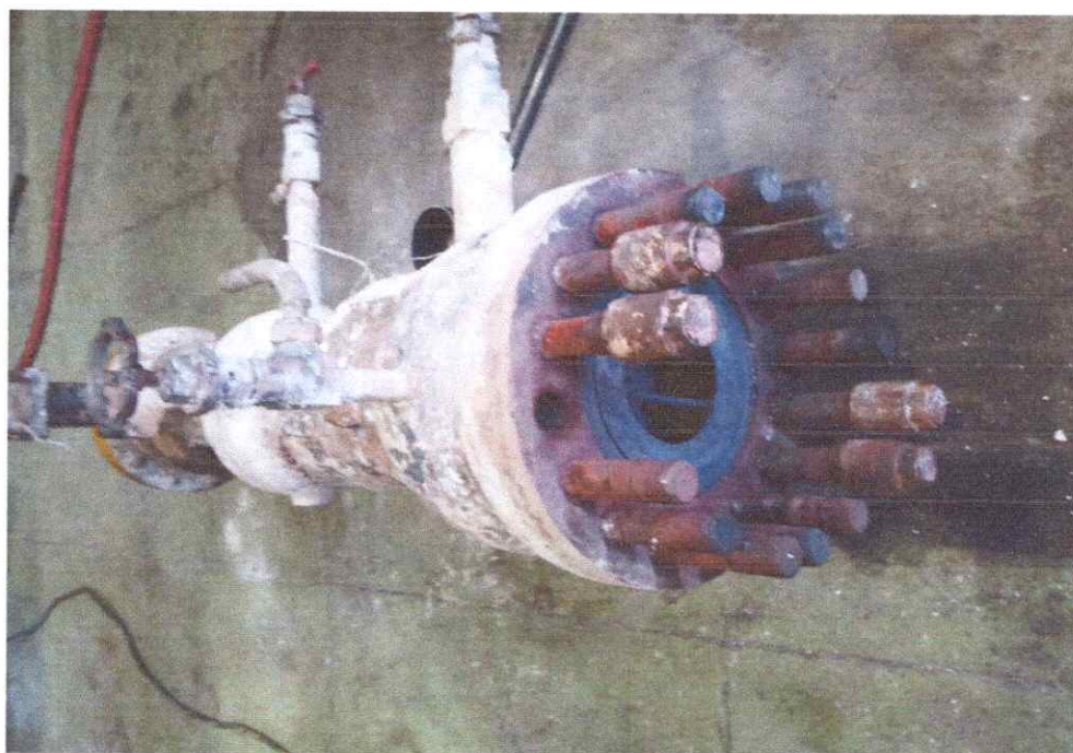
8-р зураг. “ТГ-8” турбины зогсоох хаалтны зэвэрч, хуучирсан байдал
