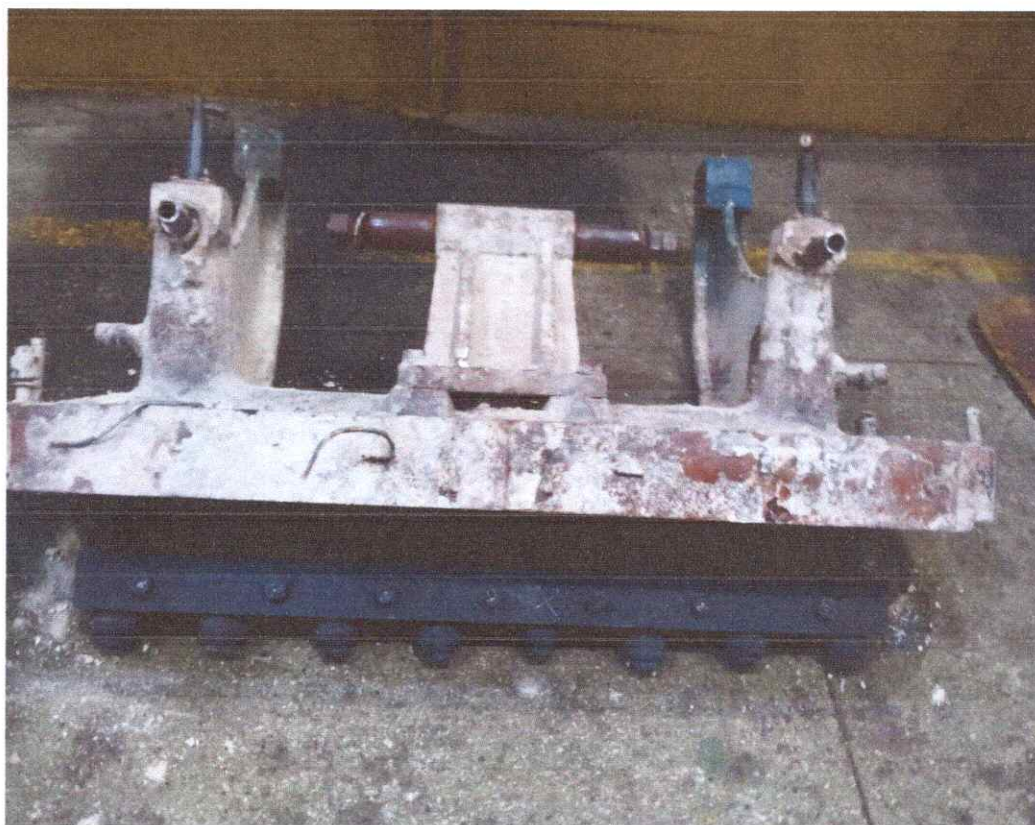
7-р зураг. “ТГ-8” турбины бүлэг хавхлагуудын зэвэрч, бохирдсон байдал
