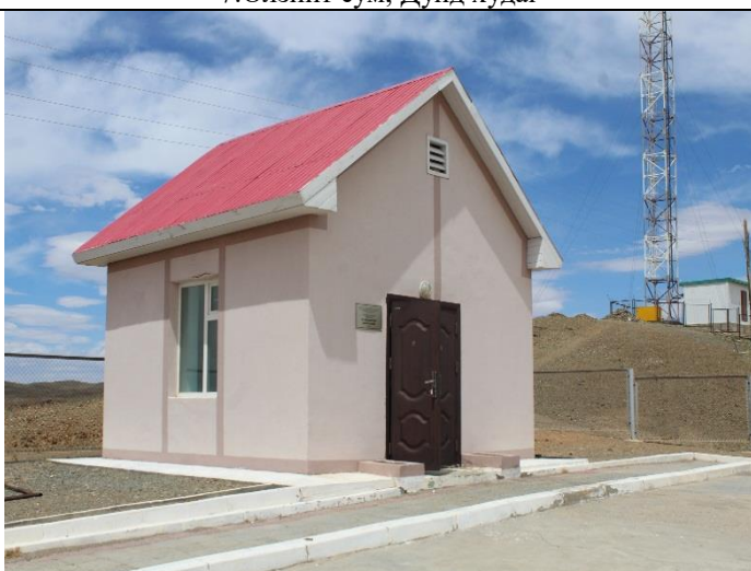
8.Өлзийт сум, Цэвэршүүлэх станц
