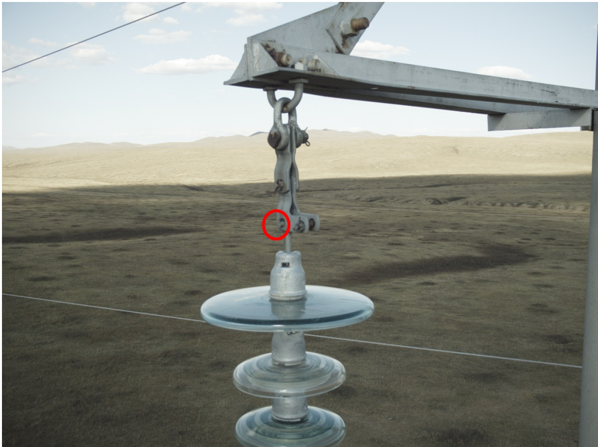
Зураг 1.7 Боолтны гайк нь унасан байгаа байдал
