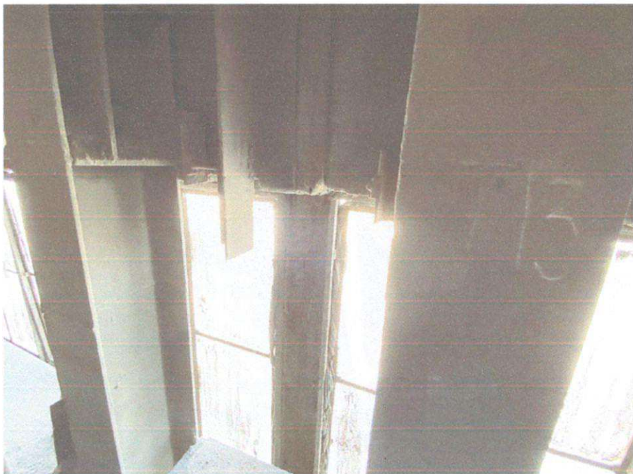
Зуухны тулгуур баганы хобосууд цэвэрд хучигдсэн байдал
