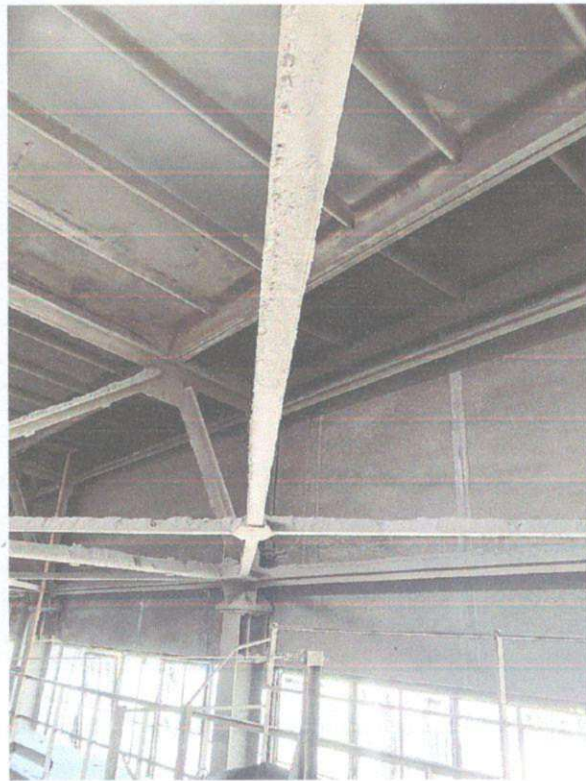
T12 ба T13 тулгуурын хоорондох татанга муруйж гулзайсныг эгц доороос нь харуулав
