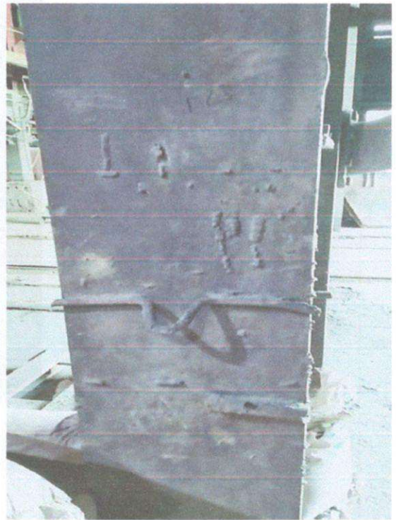
Г23 тулгуур дээр гагнуур хийсэн байна
