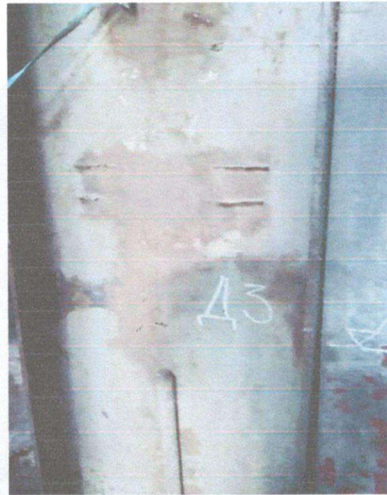
Г19 тулгуур дээр гагнуур хийсэн, зэврэлт □ссэн. Д3 тулгуур дээр гагнуур хийсэн, зэврэлт □ссэн
