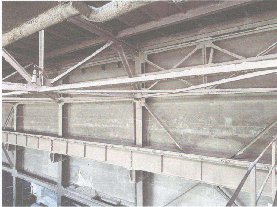
Зуухны хажуу хана болон хөндлөвчүүд цэвэрд хучигдсан байдал
