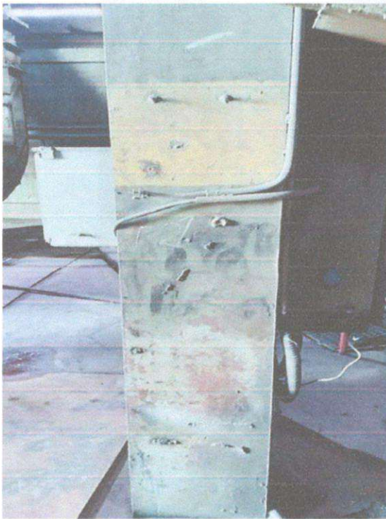
Г21 тулгуурт гагнуурт гагнуур хийгдсэн байна
