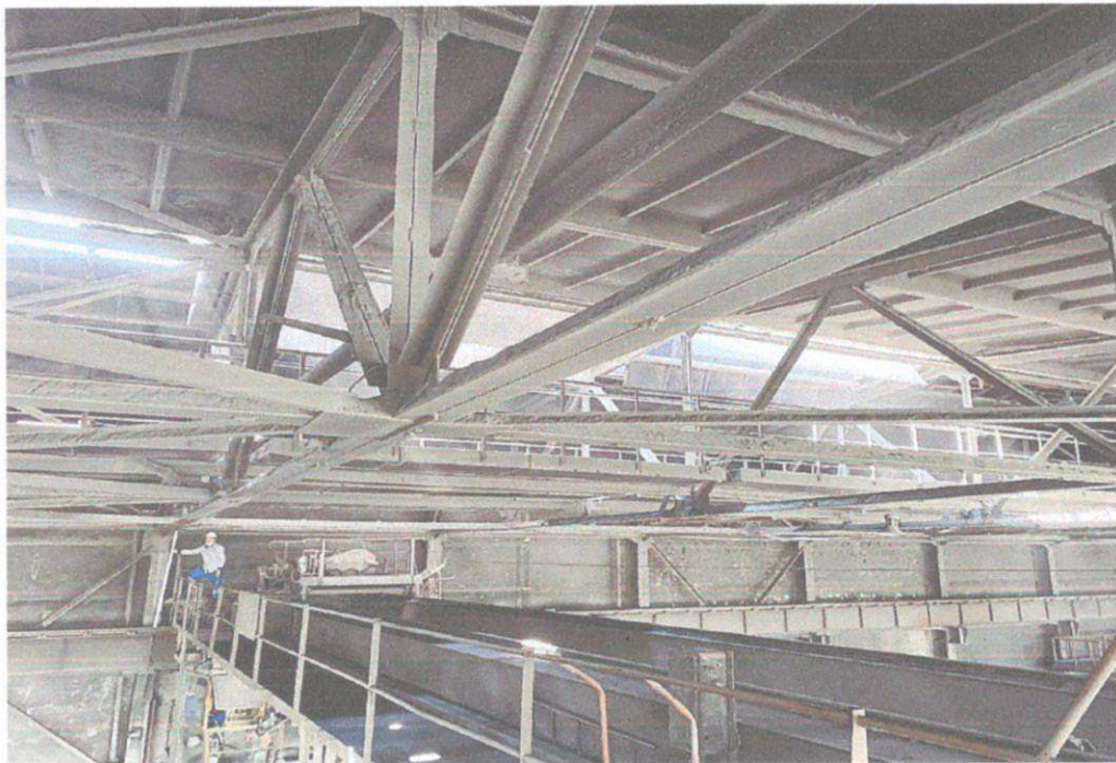
Тулгуурын багананы холбоос, татанга Үнсэнд хучигдсан байдал
