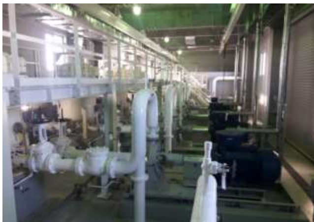
Зураг 2.15. Шатахууны агуулахын насосны станц
