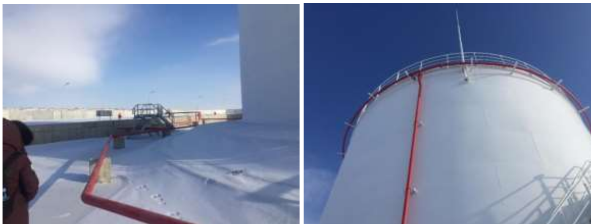
Зураг 2.17. Сав хөргөх, усан хөшиг үүсгэх тоног төхөөрөмжийг байрлуулсан байдал
