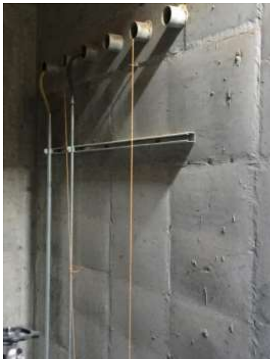
Зураг 6.6. Технологийн худагт хэмжилтийн тоног төхөөрөмжийн утас байрлуулсан байдал
