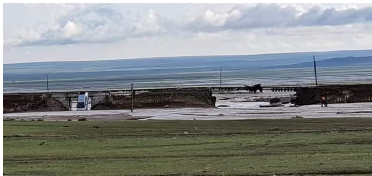
Зураг 62. Үерийн усанд угаагдсан төмөр замын ул шороо (Төв аймаг, 2020 он)
