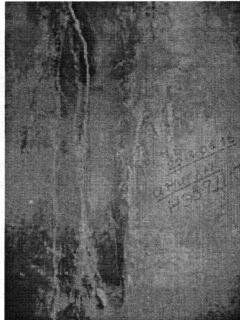
Зураг-1.42. Өмнө нь нэвчилт явагдаж байсан цэгүүд дээр усны нэвчилт ажиглагдаагүй, зөвхөн хуучин ул мөр үлдсэн байдал
