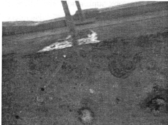
Зураг.1.8. Бохир ус тунгаагуурын ус халиах сувгийн хана, ёроолд үүссэн бетоны өгөршилт
