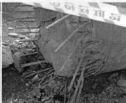
Зураг.1.32. Ан цаваар ус нэвчиж бетон арматурыг өгөршүүлсэн байдал
