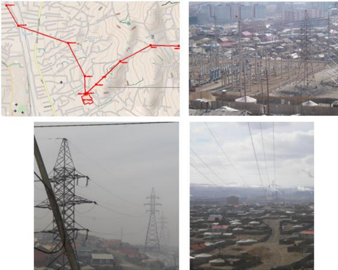
2 дугаар зураг. Дорнод -2 дэд станц, хамгаалалтын зурваст байгаа нэгж талбаруудын харагдах байдал
