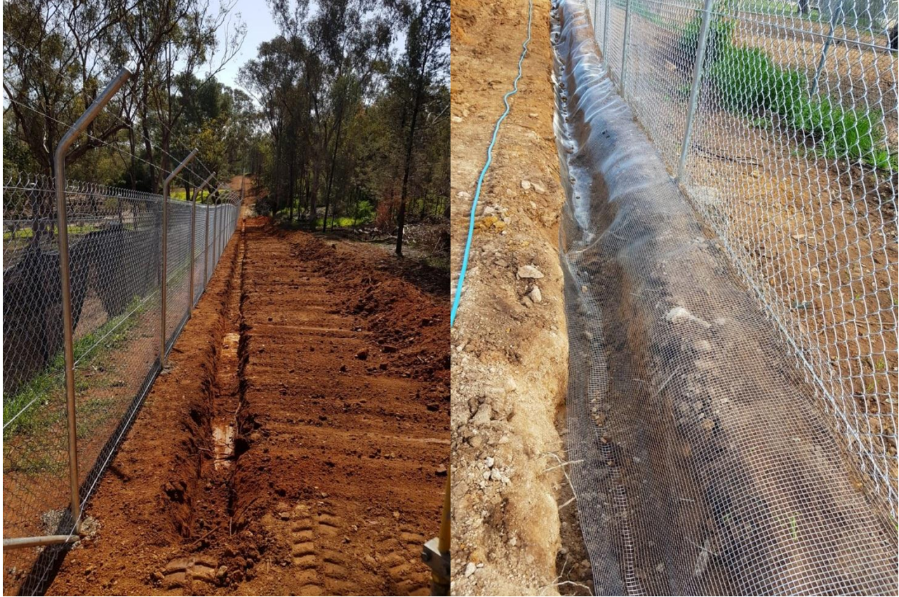
Зураг 5.2. Торон хашааны дээгүүр өргөст тор татах ба хашааны ёроолоор төмөр тор байрлуулна.
