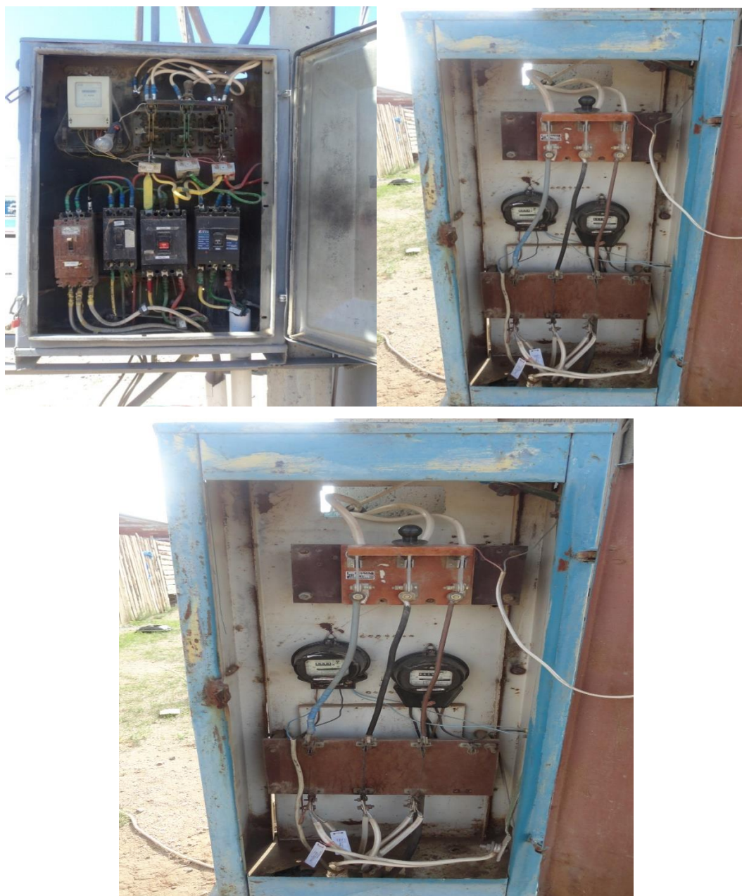
Зураг 2.14 Дэд станцуудын гаргалгааны Щитъний байдал
