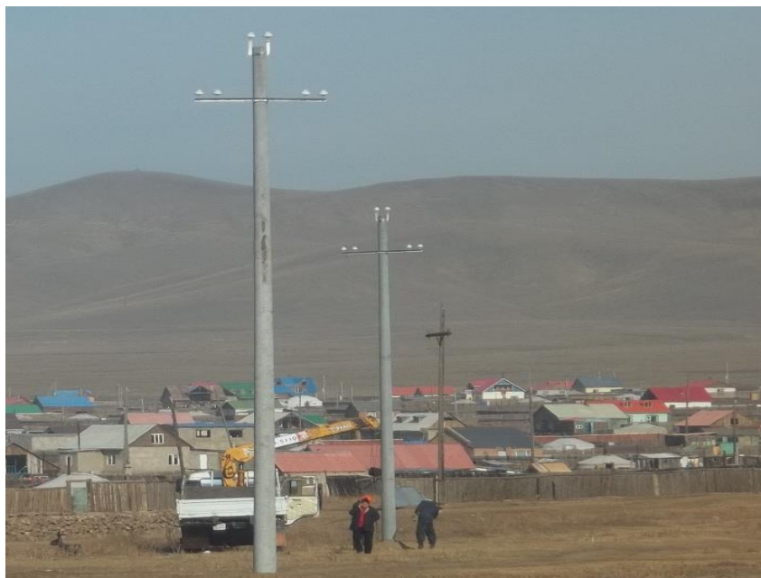
Зураг 2.16 10кВ, 6кВ-ын ЦДАШ-ыг угсаралт хийх байдал
