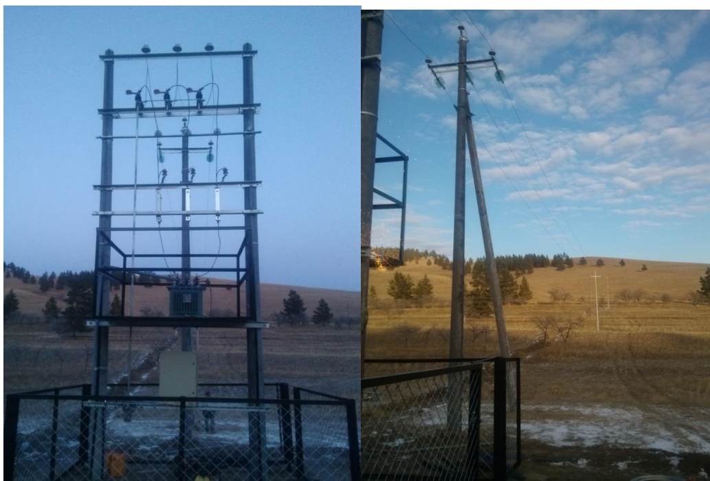
Зураг 2.17 10/0.4кВ, 6/0.4кВ-ын дэд станцыг угсах байдал
