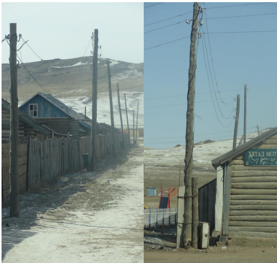
Зураг 2.8 Гэр хороололд ашиглагдаж байгаа 0,4кВ-ын салбар шугамын байдал
