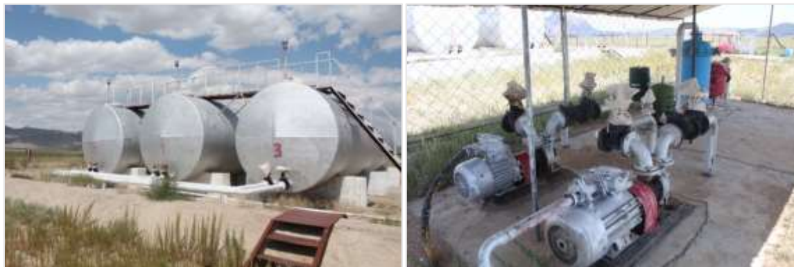
Зураг 2.16. "Ховд" нисэх буудлын шатахуун нөөцлөх сав ба насосын станц
