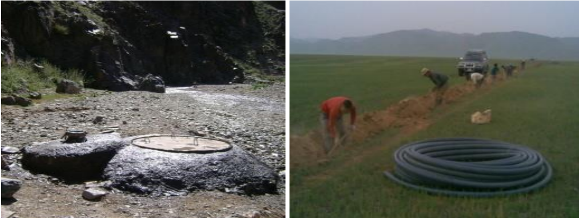
Зураг 61. Толгойн байгууламж ба ус дамжуулах хоолойг суурилуулж буй байдал
