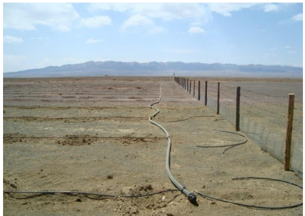
Зураг 31. Ойн зурвас байгуулах талбайд дуслын усалгааны систем байрлуулсан
