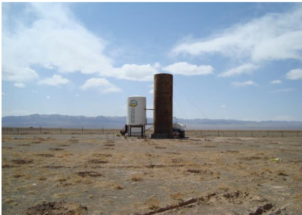
Зураг 30. Гүн өрмийн худаг гарган ус нөөцлөх савыг байрлуулсан төрх байдал (Өмнөговь аймаг, Монгол, Солонгосын
