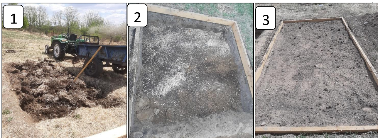
Зураг 39. Талбай бэлтгэсэн байдал
