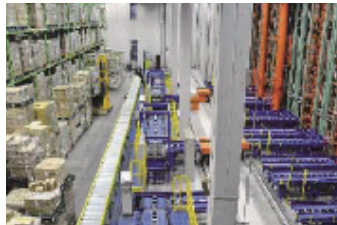
Picking station 자동창고 내에 보관된 Pallet를 출고시켜 상품박스를 피킹하고 잔량은 재 입고시키는 설비
