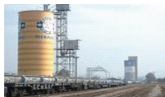
SILO (시멘트 저장고)
