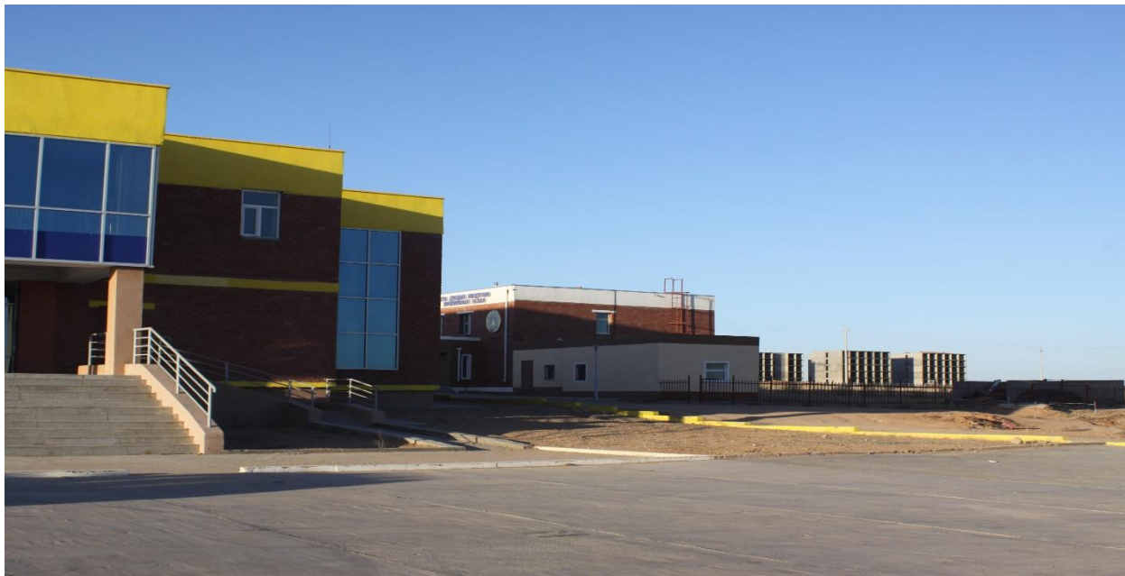
Зураг 24. “Өмнөговь аймаг Ханбогд” сумын шинээр ашиглалтад орсон Соёлын төв ордон, баригдаж буй орон сууцны барилга
