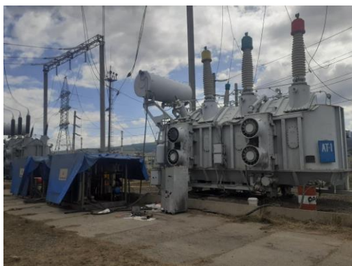
Зураг 2. Цэвэрлэх төхөөрөмжийн трансформаторт холбосон байдал
