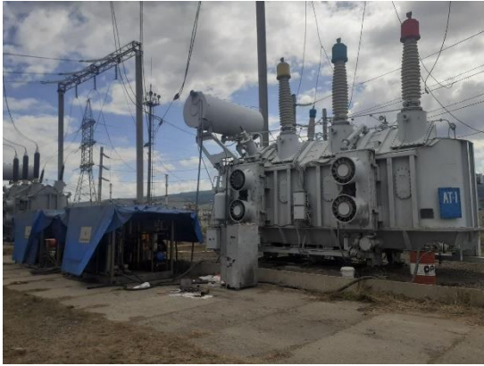
Хүснэгт 22. Цэвэрлэх төхөөрөмжийн трансформаторт холбосон байдал
