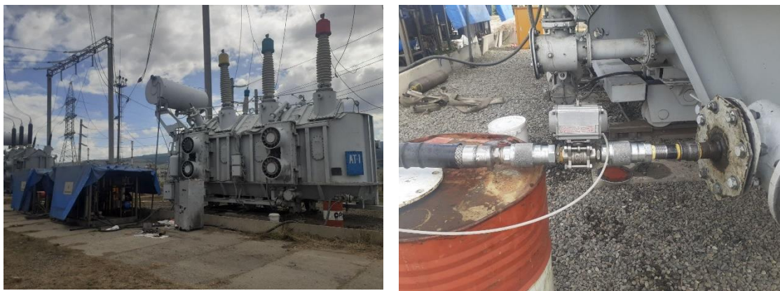
Зураг 20. Цэвэрлэх төхөөрөмжийн трансформаторт холбосон байдал
