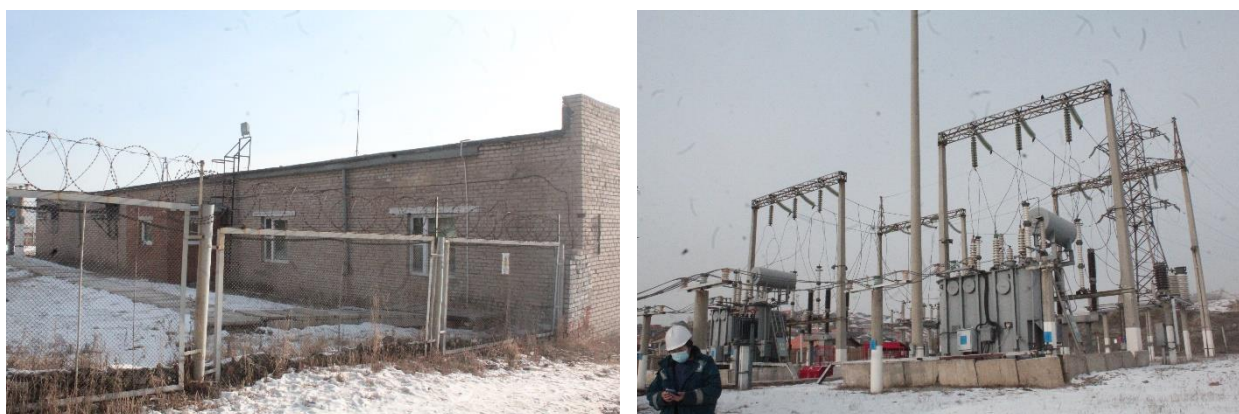
Зураг 3. Талбай доторх барилгабайгууламж болон дэд станц
