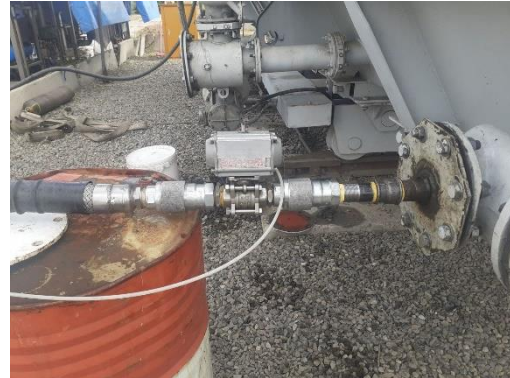
Зураг 18. Цэвэрлэх төхөөрөмжийн трансформаторт холбосон байдал
