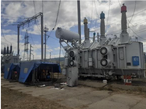
Зураг 18. Цэвэрлэх төхөөрөмжийн трансформаторт холбосон байдал
