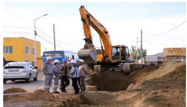
/СХД, 26-Р ХОРОО, ЦЭВЭР, БОХИР УСНЫ ШУГАМЫН ХОЛБОЛТЫН АЖИЛ/
