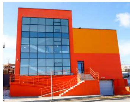
/Сэлбэ дэд төвийн цахилгаан холбооны барилга/
