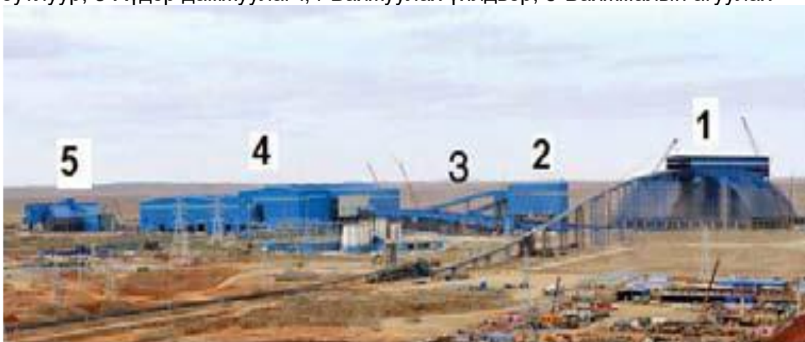
Зураг 15. Баяжуулах үйлдвэрийн цогцолбор: 1-Хүдрийн агуулах, 2-Хоёрдогч бутлуур, 3-Хүдэр дамжуулагч, 4-Баяжуулах үйлдвэр, 5-Баяжмалын агуулах
