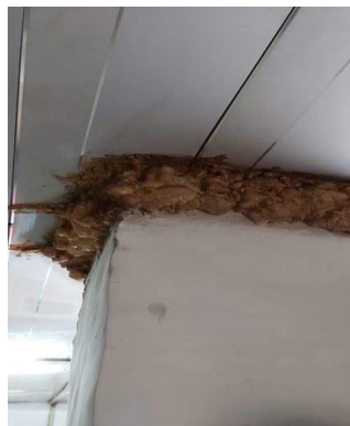
Дүрслэл 4. Яндангийн битүүмжлэл муу, дахин битүүмжилсэн байдал
