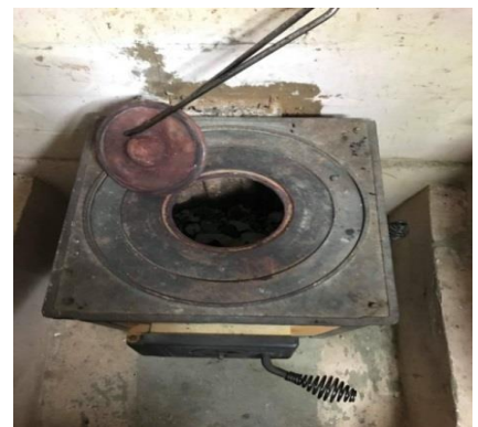
Дүрслэл 4. Яндангийн битүүмжлэл муу, дахин битүүмжилсэн байдал
