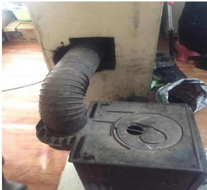
Дүрслэл 4. Яндангийн битүүмжлэл муу, дахин битүүмжилсэн байдал
