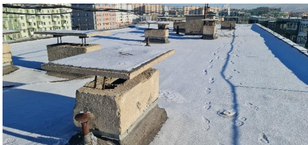
Зураг 21. Дээврийн агаар зайлуулах шахтын байдал болон агаарын зарцуулалтын хэмжилт
