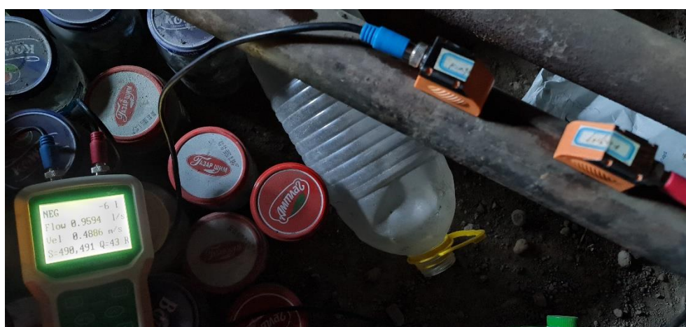
Зураг 15. 9 давхар угсармал орон сууцны зоорины давхар дах дулааны зангилаанд тоолуур суурилуулсан байдал.
