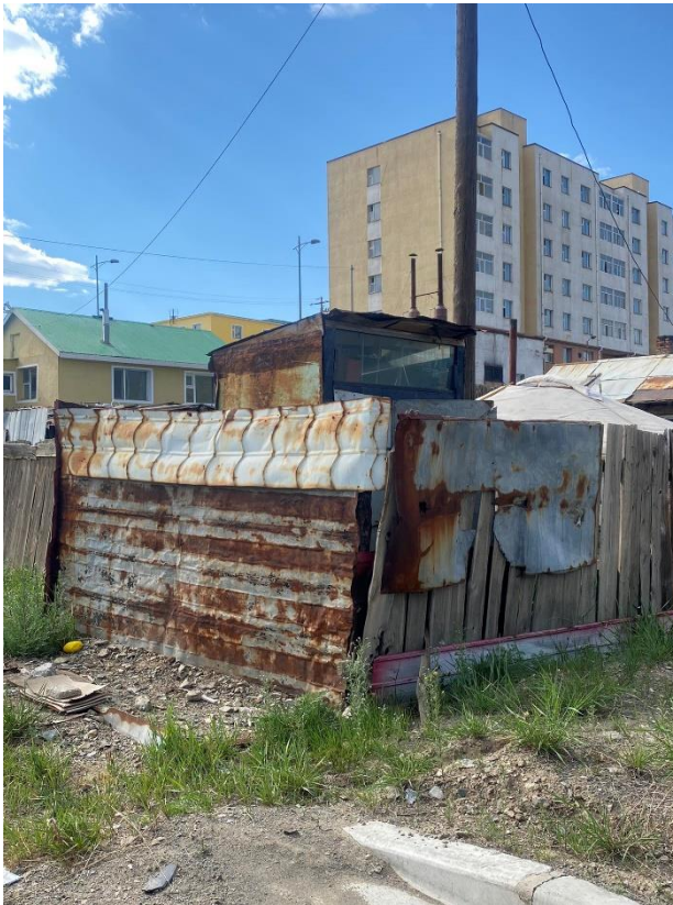
Зураг 59. Одоогийн байгаа нүхэн жорлон ба бохир усны төвийн шугаманд нийлүүлээгүй байдал
